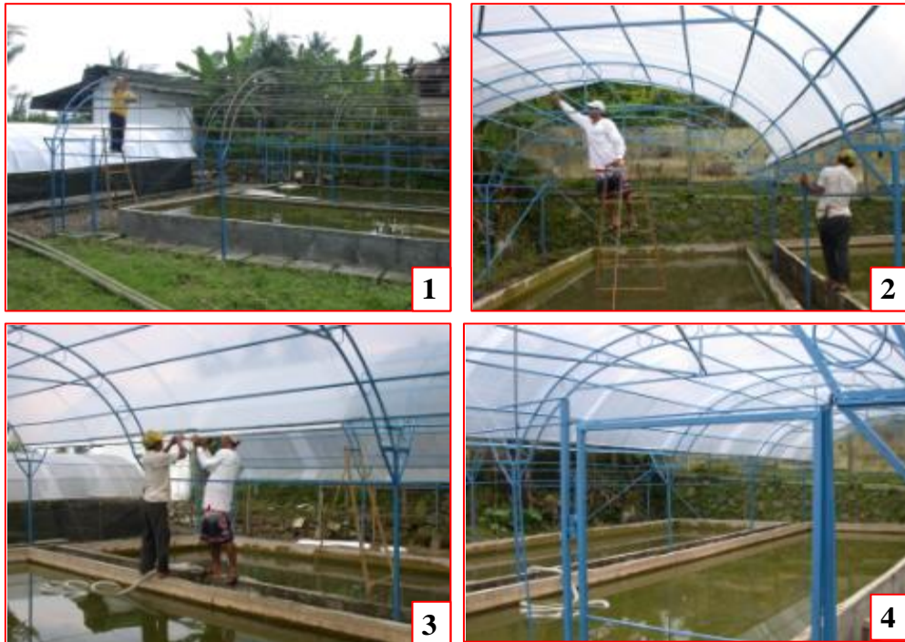
Gambar 2. Persiapan greenhouse dan kolam tanam. (1). Instalasi kerangka greenhouse , (2). Pemasangan UV Plastik, (3) Benguncian UV Plastik pada kerangka Greenhouse, (4) Greenhouse dan bak tanam yang siap dipakai.
